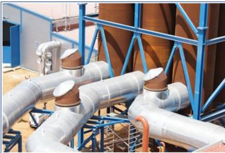
*Fig. 4. Discos de ruptura en tuberías.*
