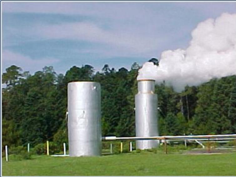
*Fig. 2. Un silenciador portátil y otro permanente de acero al carbón, el del fondo con captador de humedad en su parte superior.*
