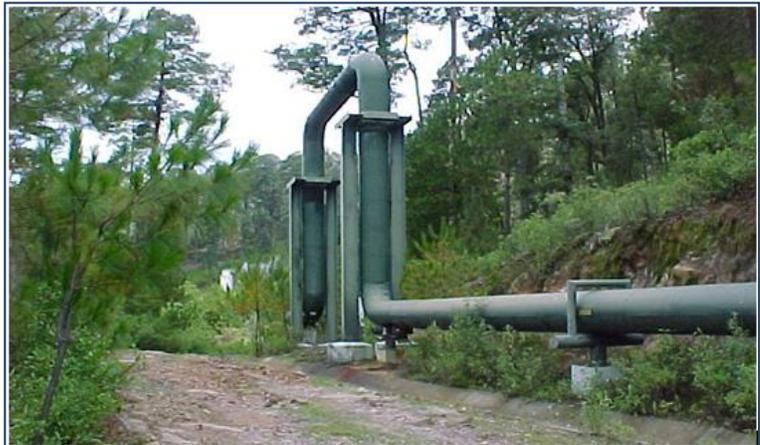
Fig. 5. Vaporducto instalado a un lado de un camino preexistente, mostrando su soportería y una omega vertical para absorber esfuerzos térmicos.
