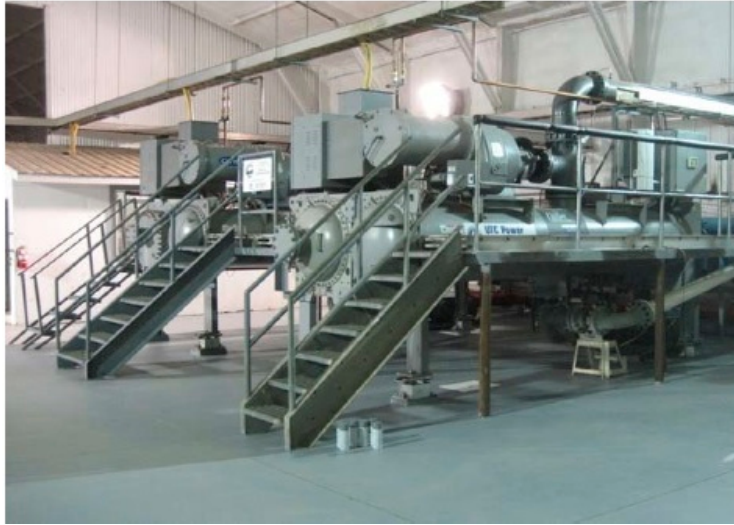
Figura 49: Vista dentro de la Casa de Máquinas con las 2 unidades de 200 kW cada una
