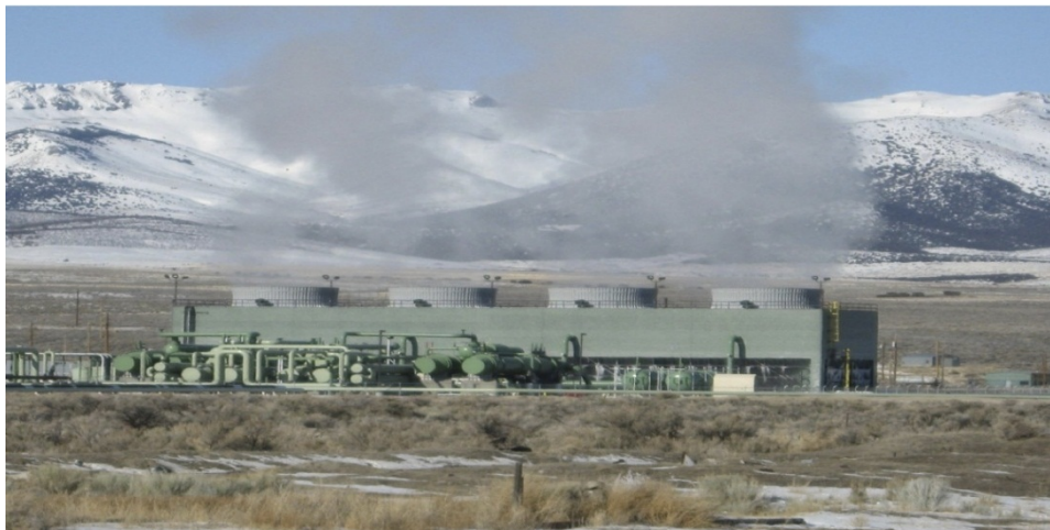
Figura 51: Central de Ciclo Binario en Raft River NV
