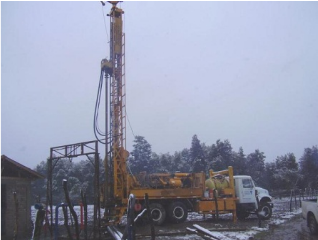
Figura 21: Equipo para perforación de pozos
