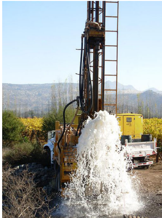
Figura 22: Descarga de un pozo de agua.
