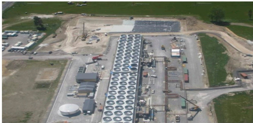
Figura 55: Central de Ciclo Binario de 23 MW instalada en Te-Huka, NZ.
