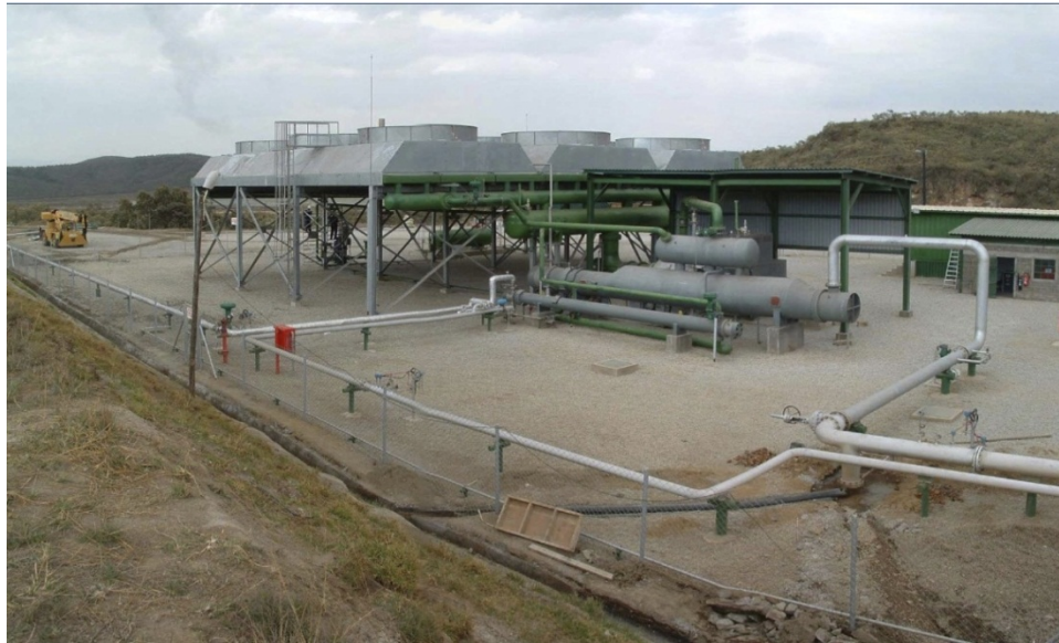
Figura 54: Vista de la unidad binaria de 1.8 MW instalada en Oserian
