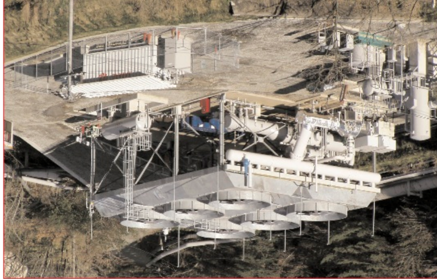
Figura 57: Central de 2 MW de ciclo binario instalada en Hatchobaru, Japón
