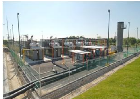
SISTEMA DE EXTRACCIÓN Y QUEMADOR DE BIOGÁS
