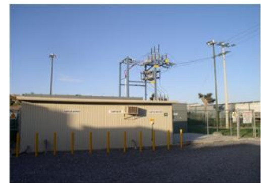
SUBESTACIÓN Y MEDICIÓN
